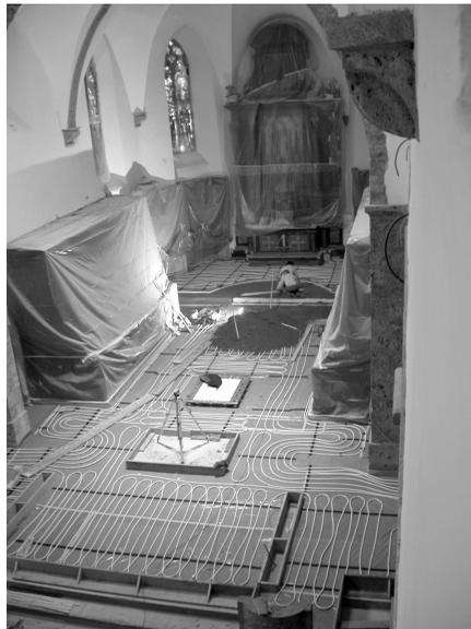
*On a profité du chantier pour installer dans le chœur un chauffage par le sol.*
